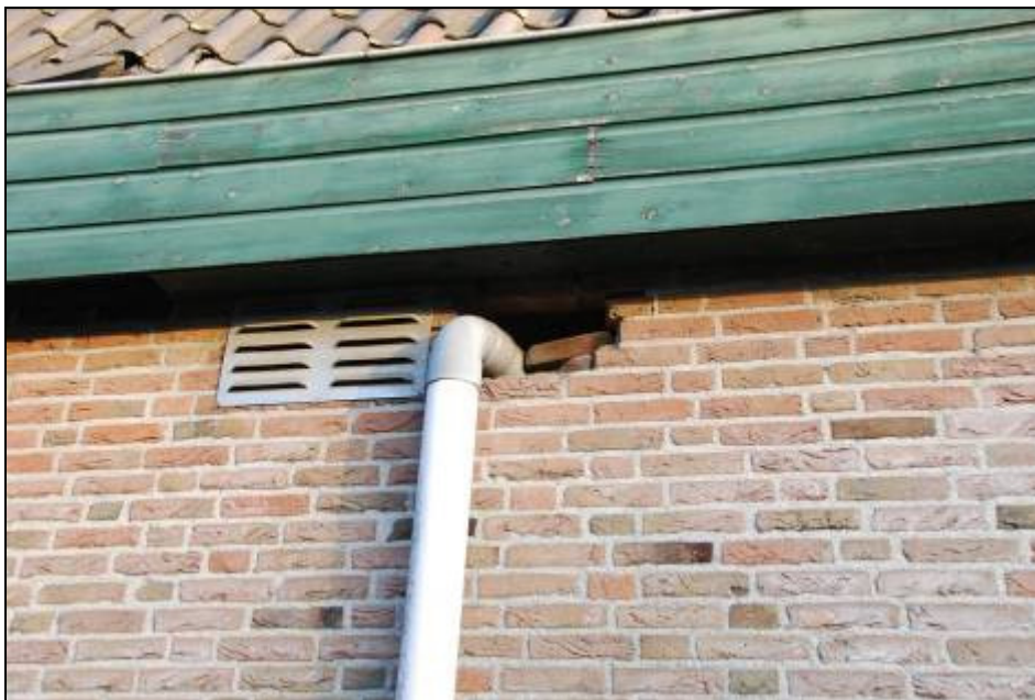
Figuur 3.2.4-1: Voor vleermuizen toegankelijke spouwmuur aan de achterzijde van het gebouw.
